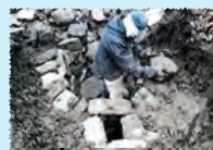
3.炭焼き窯をつくる炭材に合わせて移動。
